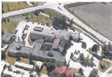
Terveyskeskuksen vanhin osa kuvan keskellä, alueella näkyy Anttilan ent. päärakennusta.
